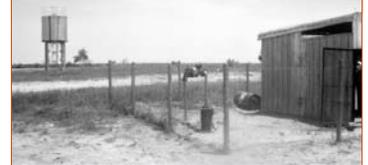
**En haut :** Le puits de Baggam. 120 m de profondeur, creusé à la pioche à travers deux couches de grès qui représente 3 ans de travaux. Il offre 4 postes de travail, mais sa margelle en ciment n'a pas la hauteur suffisante.
