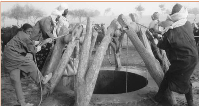
Sur cette page, deux puits traditionnels de 80 m de profondeur. Le puits de Baggam, quant à lui, a été creusé à la main à 120 m de profondeur. Il a représenté 3 ans de travaux et nécessite 3 postes de travail.
